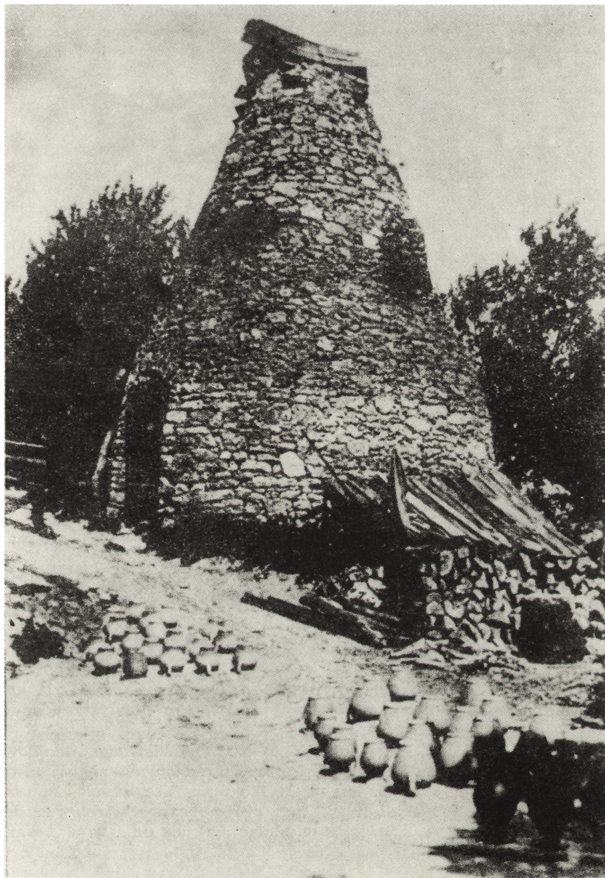
Ryc. 1. Piec garncarski używany w XIX wieku przez garncarzy ilżeckich do wypalania naczyń
