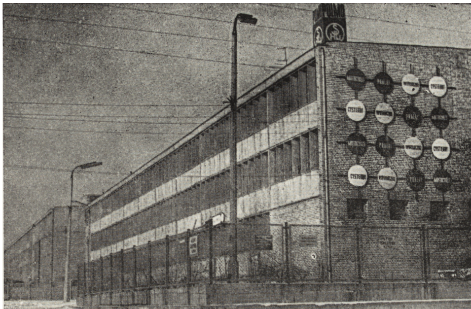
Ryc. 3. Matrycownia i Centralna Tłocznia Kieleckich Zakładów Wyrobów Metalowych
