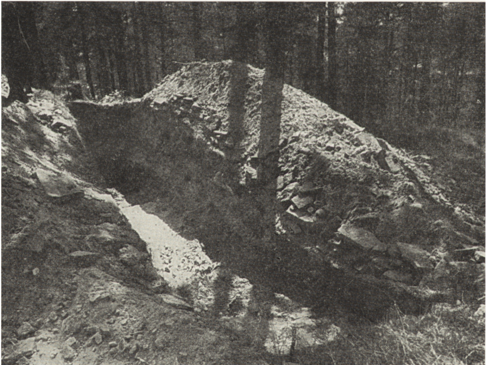
Ryc. 3. Widok wykopu II w miejscu przecięcia wału
