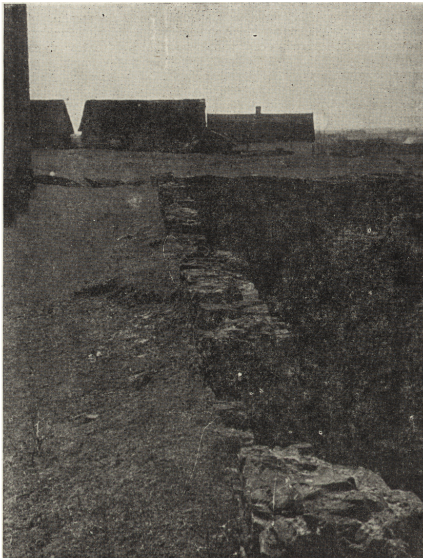
Ryc. 16. Krzyżtopór. Relikty przedpiersia kurtyny III—IV. Stan z 1959 r.
