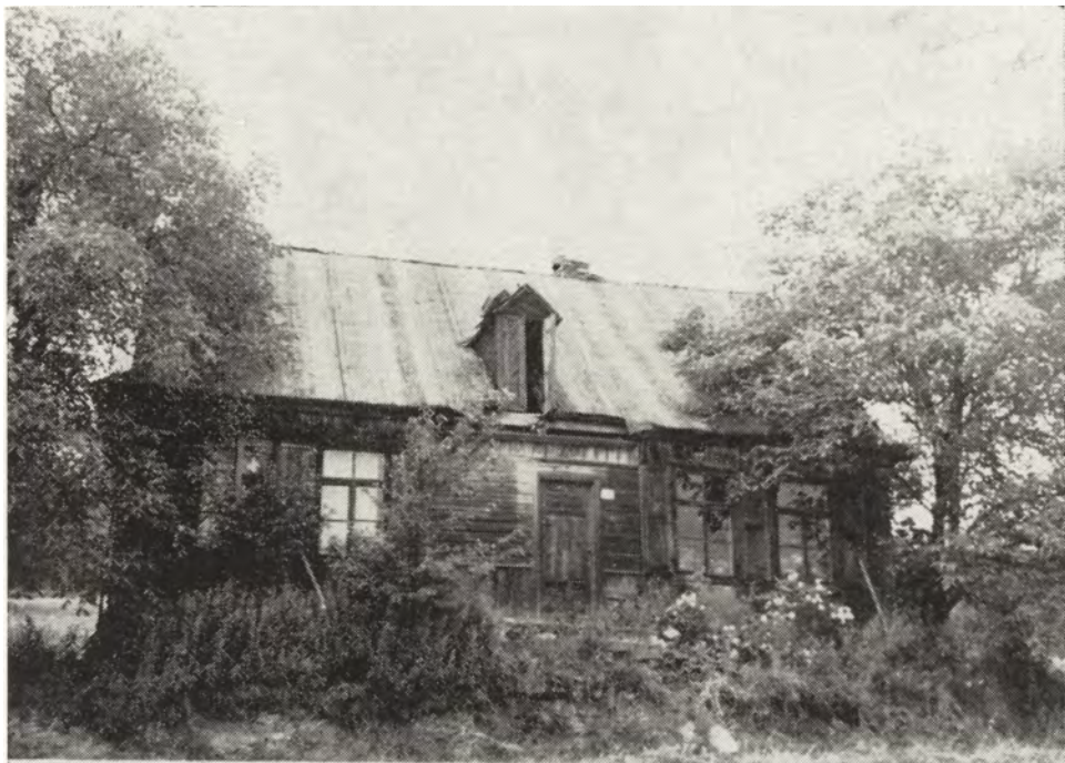
Ryc. 11. Dom dwutraktowy z sienią usytuowaną centralnie, pierwotnie przed wejściem znajdował się ganeczek, 1924 r., Kakonin 67
