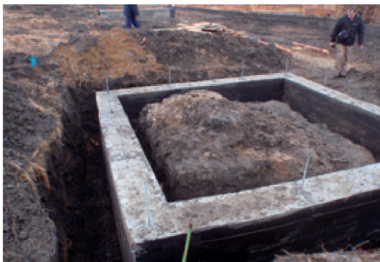
Wkop oraz ławy fundamentowe jednego z budynków „rekonstruowanych” na grodzisku w Owidzu, (fot. Paweł Marek Pogodziński).
