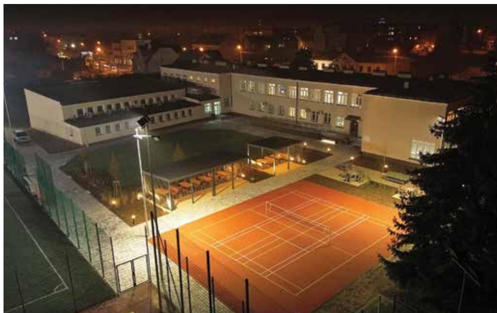
Ryc. 9. Inwestycja „Zagospodarowanie terenu przy Zespole Szkół nr 2”
