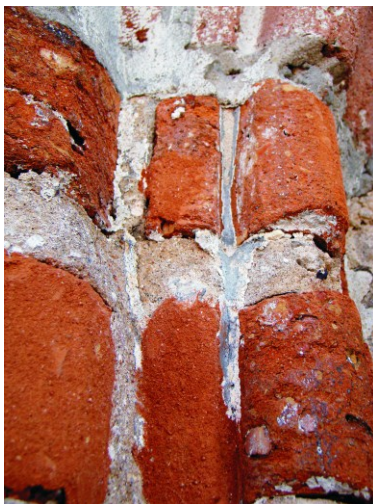
Il. 11. Elewacja frontowa, szczyt, służka między blendami, przykład zachowania śladów pierwotnych warstw malarzkich po oczyszczeniu w 2010 r. Fot. Z. Nawrocki 2010
