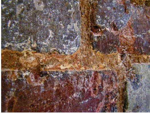
Il. 8. Elewacja frontowa, parter, przykład zachowania lica cegieł i spoin po oczyszczeniu w roku 2010. Fot. Z. Nawrocki 2010
