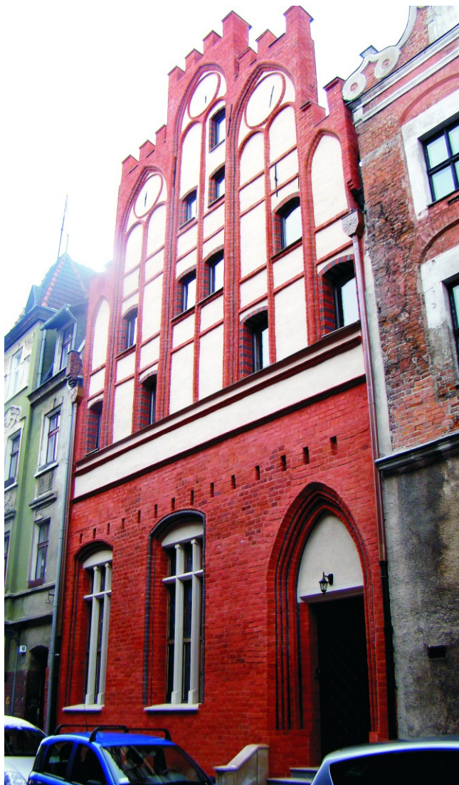
II. 2. Elewacja frontowa dzisiaj. Fot. Z. Nawrocki 2012
