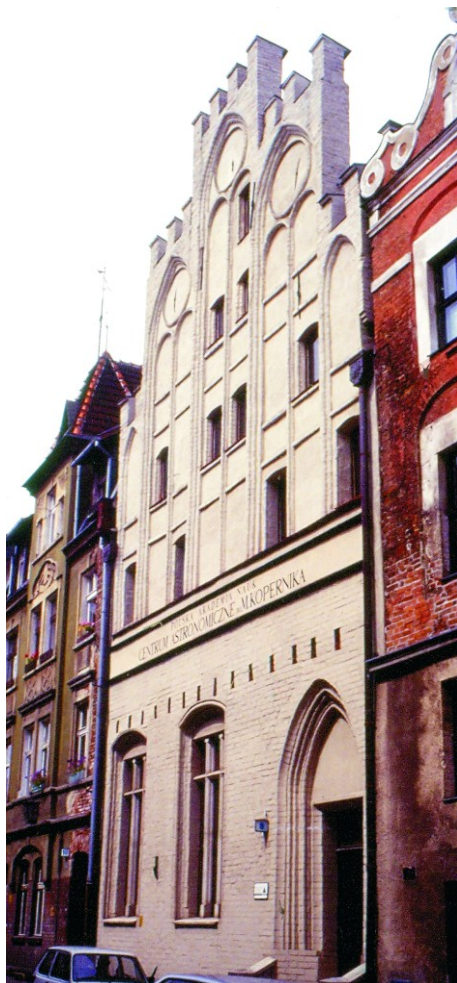
Il. 1. Elewacja frontowa przed 2010 r. Fot. Z. Nawrocki
