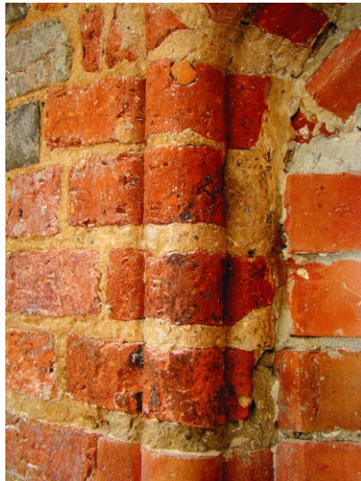
Il. 9. Elewacja frontowa, szczyt, przykład pierwotnego opracowania spoin i uzupełnienia ubytku cegły, stan po usunięciu przemalowań. Fot. Z. Nawrocki 2010
