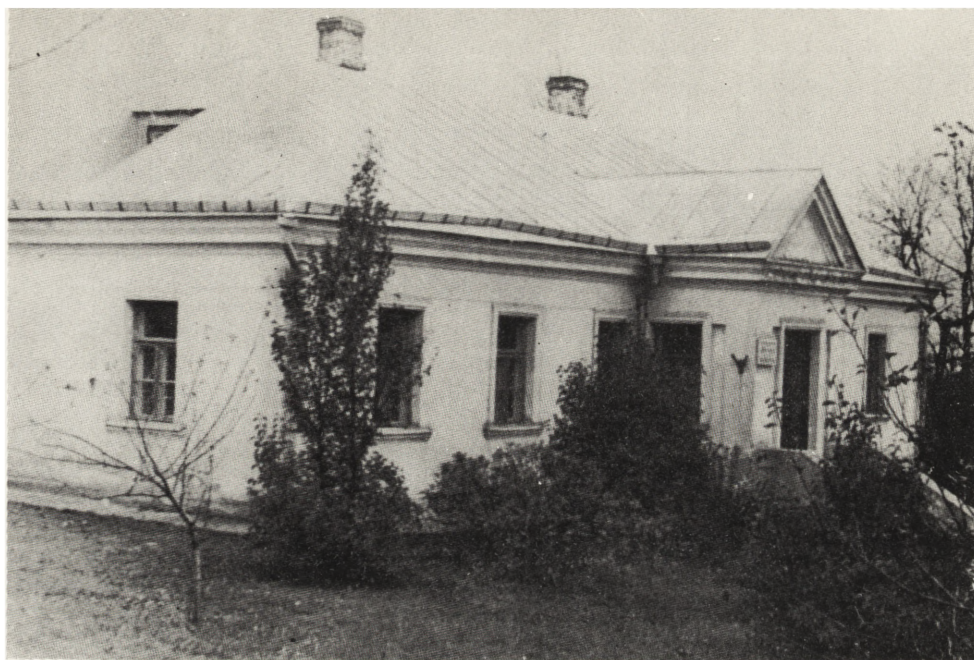
Dom-Muzeum Adama Mickiewicza w Nowogródku, stan współczesny po odbudowie
