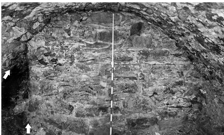
Fot. 4. Wykop V – starsza wschodnia ściana piwnicy, fundament domniemanej wieży, obudowanej sklepieniem (fot. M. Ignasiak).
