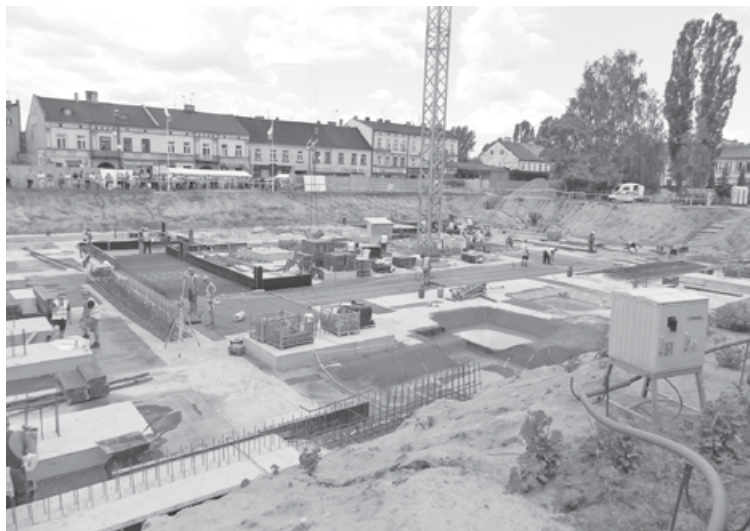
Ryc. 1. Budowa ZCI „Ratusz” w Zduńskiej Woli, lipiec 2012
