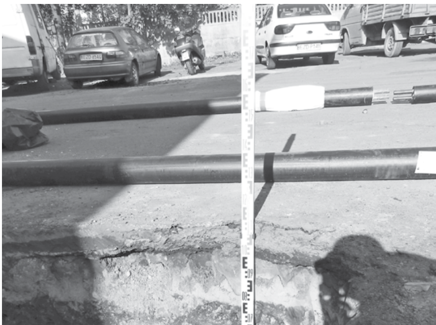
Ryc. 11. Profil wykopu na podwórzu posesji Plac Wolności 16
