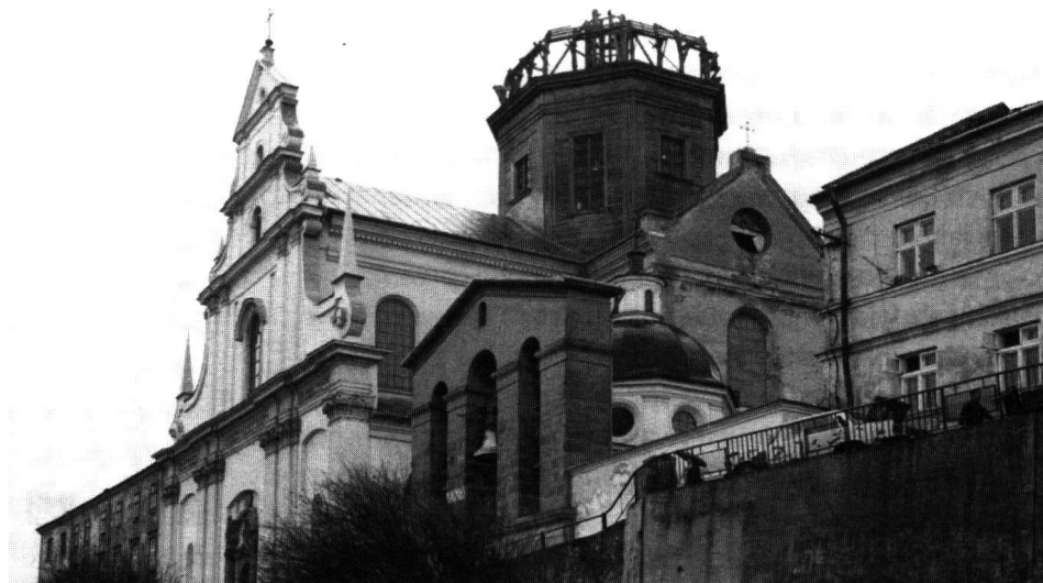
Fot. 3. Rozbórka kopuły na byłej katedrze greckokatolickiej w Przemyślu (fot. z archiwum pisma „Peremyński Dzwony”)
