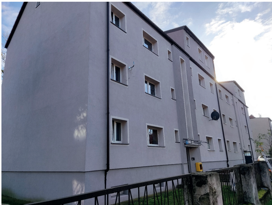
Fot. 7. Obecny wygląd domu przy ul. Rybackiej 14 i 15, po termomodernizacji (zdjęcie autora z 2022 r.)
