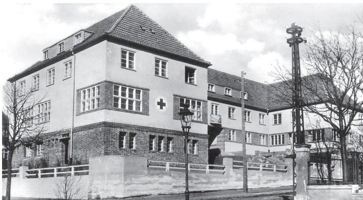
Fot. 31. Budynek PCK oraz Dom matki i dziecka w latach 1920-1930 u zbiegu Yorkstraße (Lotha) i Steinstraße (Lelewela)
