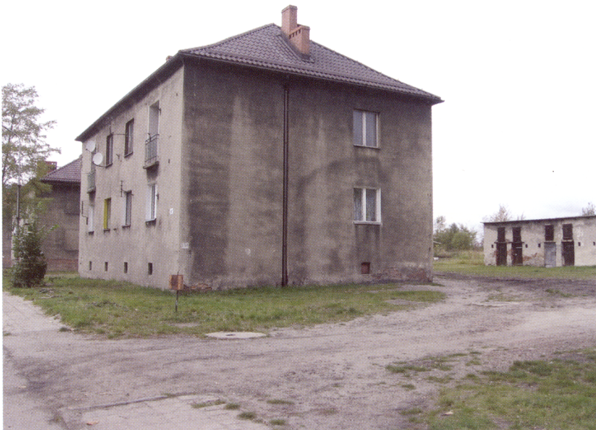
Fot. 3. Uboga zabudowa dzielnicy Słowice. Z tyłu budynku komórki do hodowli gołębi
