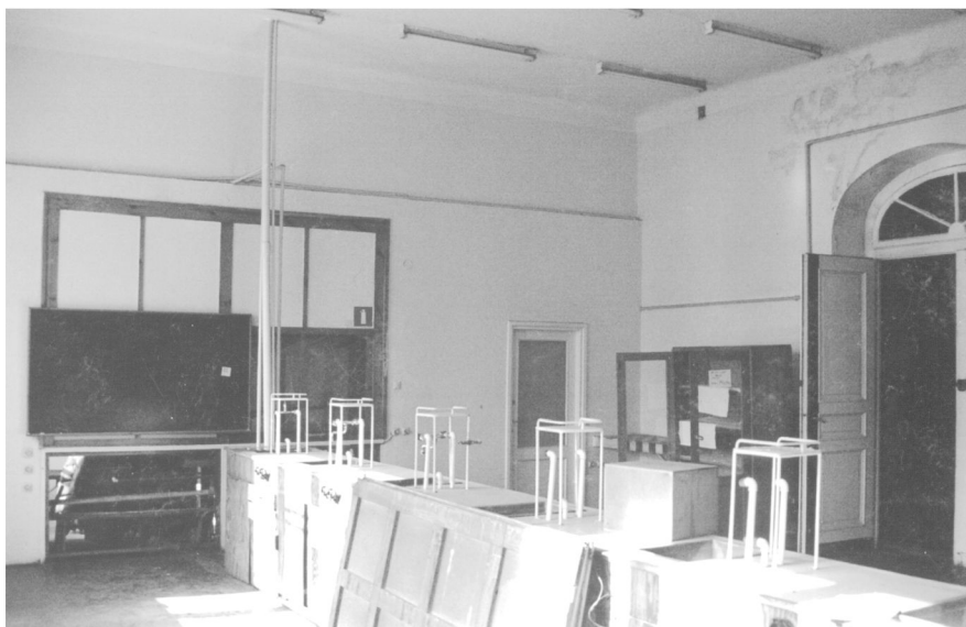
Fig. 8. Wnętrze sali wykładowej w Szkole Głównej, rok 2002 (fot. H. Kowalski)
