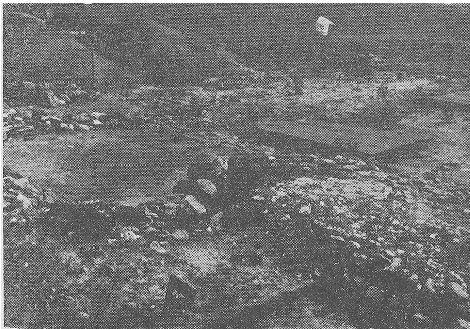
Ryc. 3. Widok na II budowlę przed konserwacją w 1983 r.
