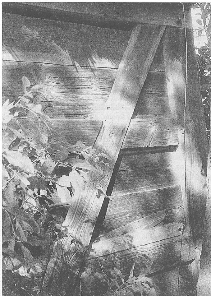
Fot. 3. Fragment stodoły konstrukcji szkieletowej: narożniak , rygiel i zastrzał łączone na tyble oraz wypełnienie szkieletu — blochy (ok. 1840 r.), Sarbinowo, 1997 r., fot. Jerzy Adamczewski
