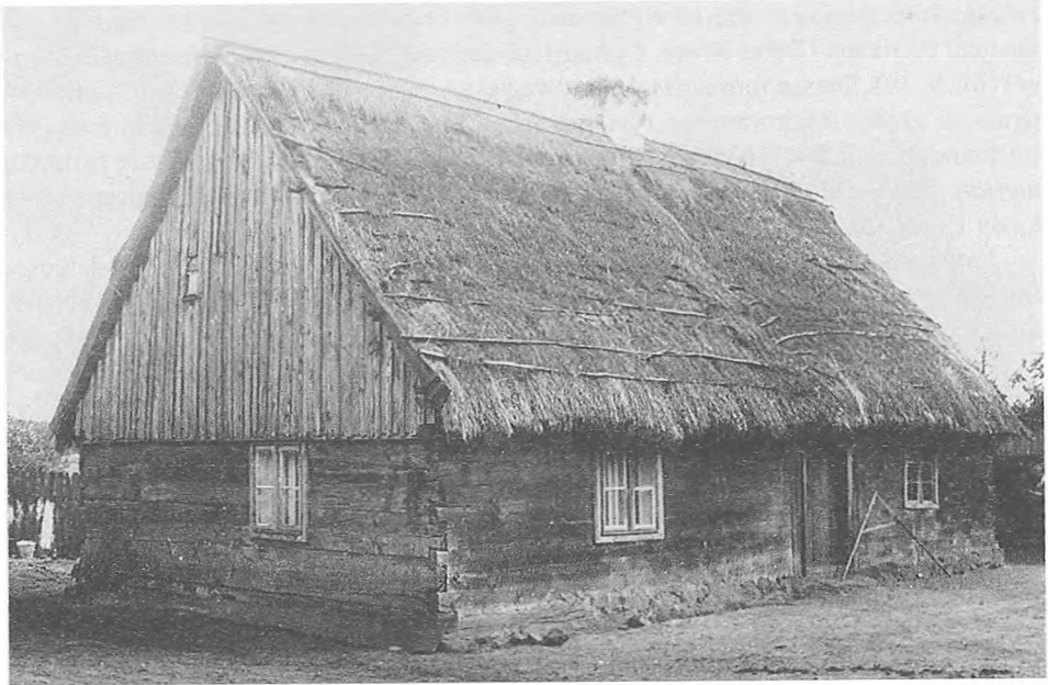
Fot. 9. Szerokofrontowa chałupa zrębowa (poł. XIX w.), Godzimirz, 1965 r., fot. Zbigniew Zgierun
