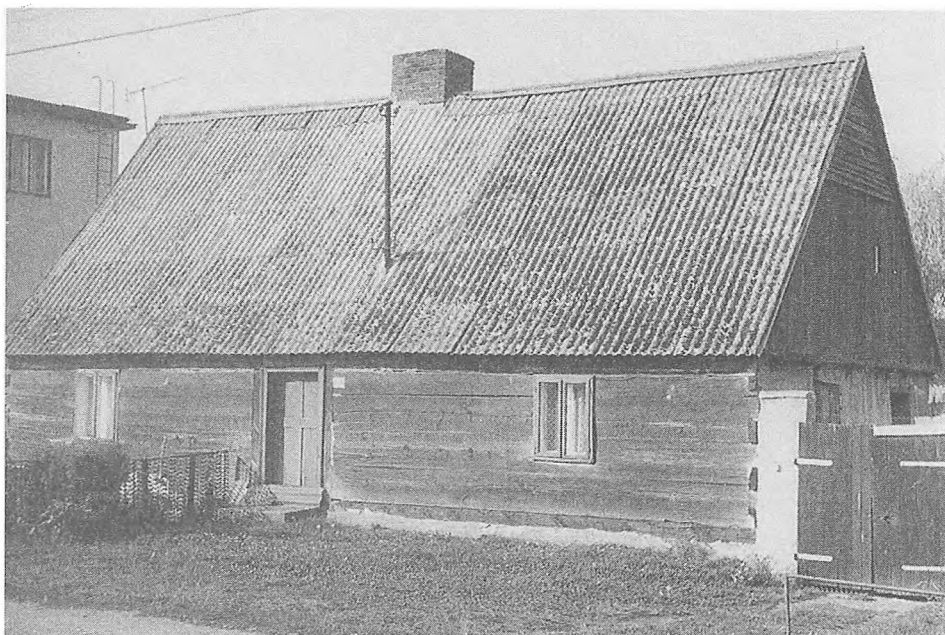
Fot. 16. Chałupa nakryta dachem dwuspadowym ze śladami naczółka (pocz. XIX w.), Sarbinowo, 1997 r., fot. Jerzy Adamczewski
