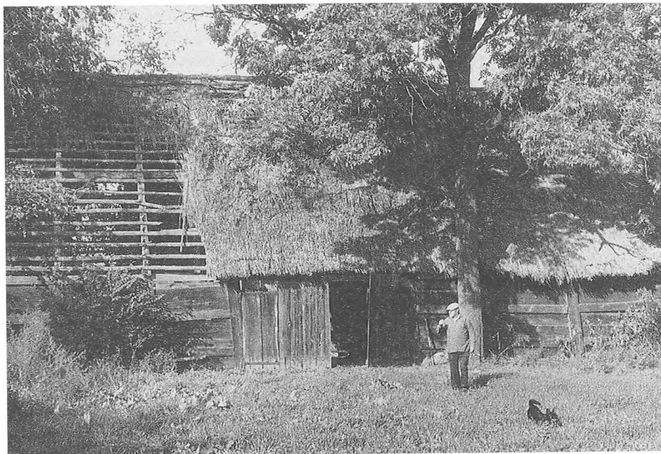
Fot. 2. Stodoła konstrukcji szkieletowej w blochy (ok. 1840 r.), Sarbinowo, 1997 r., fot. Jerzy Adamczewski
