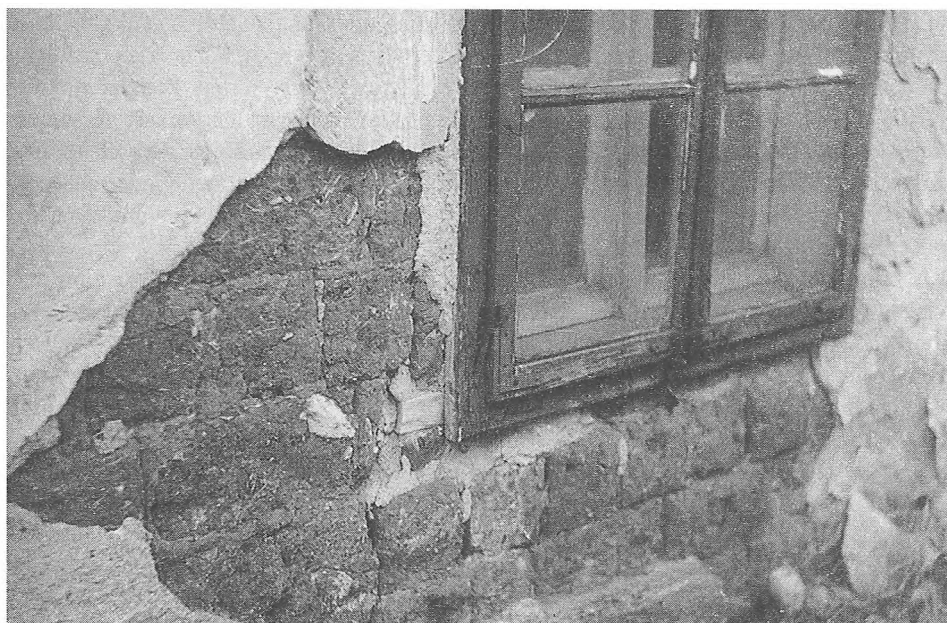
Fot. 4. Fragment ściany chałupy murowanej z glinianej pecy (k. XIX w.), Annowo, 1997 r., fot. Jerzy Adamczewski
