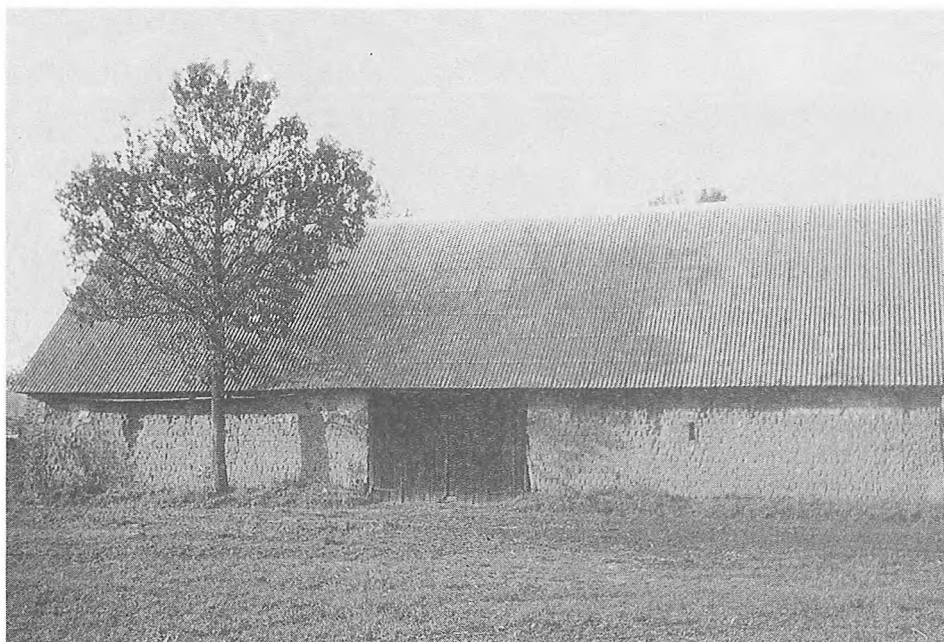
Fot. 1. Stodoła murowana z glinianej pecy (II poł. XIX w.), Ryszewo, 1997 r., fot. Jerzy Adamczewski
