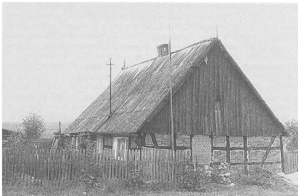
Fot. 13. Chałupa szkieletowa z ceglanym wypełnieniem — pruski mur , Godzimirz, 1997 r., fot. Jerzy Adamczewski
