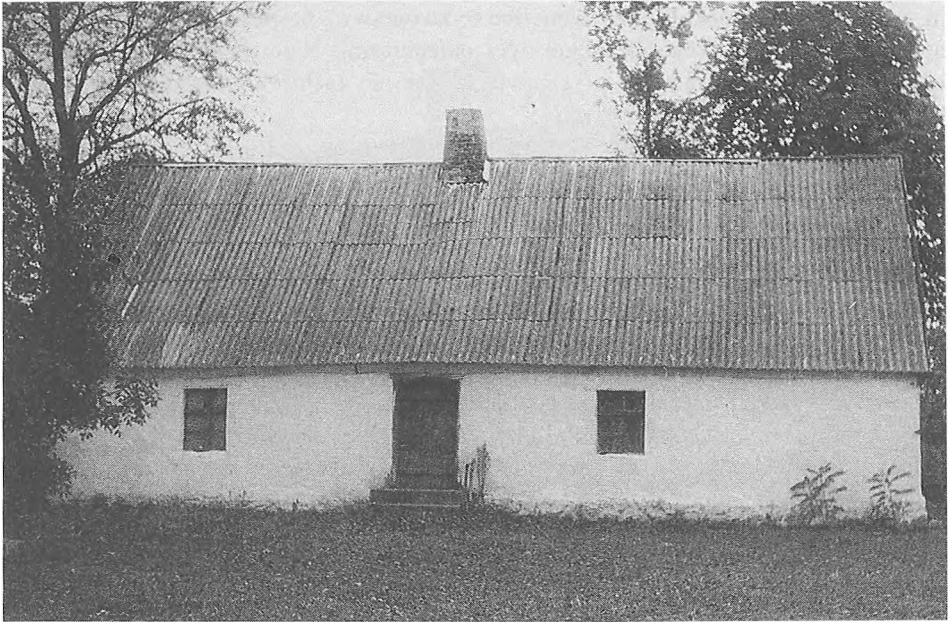
Fot. 21. Dwutraktowa chałupa murowana z pecy , bielona wapnem (1847 r.), Ochodza, 1997, fot. Jerzy Adamczewski
