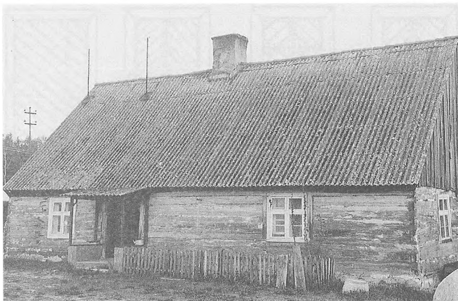
Fot. 19. Chałupa konstrukcji wieńcowej z dostawionym wtórnym gankiem (ok. 1860 r.), Szkocja, 1995, fot. Jerzy Adamczewski
