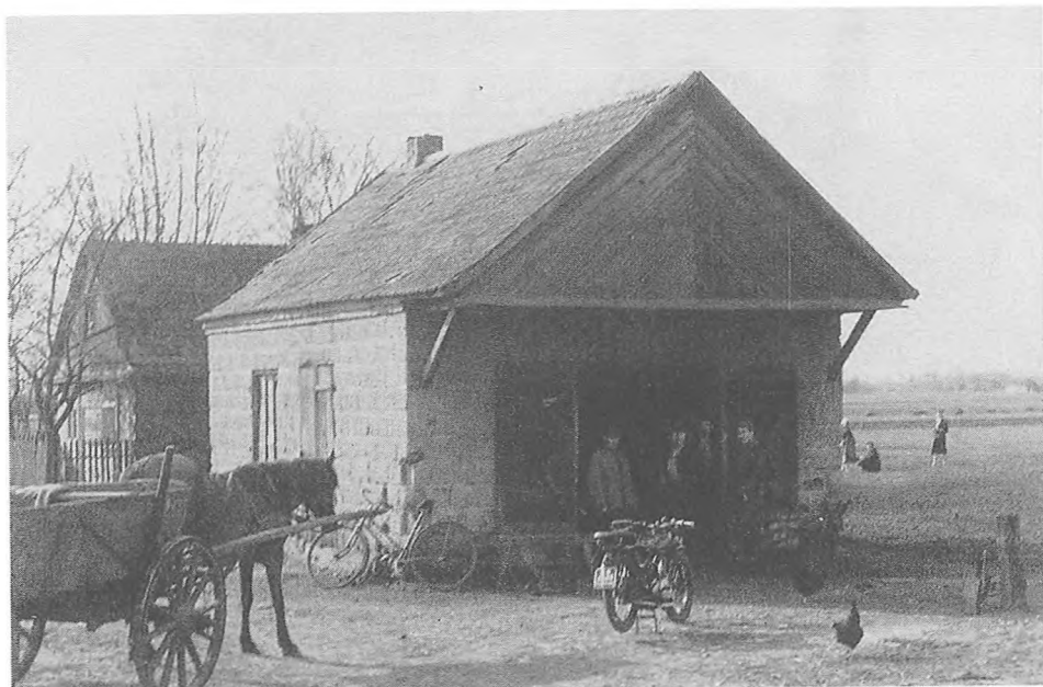
14. Dwudziestowieczna kuźnia wzniesiona z pustaków cementowych. Drożyn, pow. Sępca (stan z końca lat 50-tych XX w.), fot. J. Burszta
