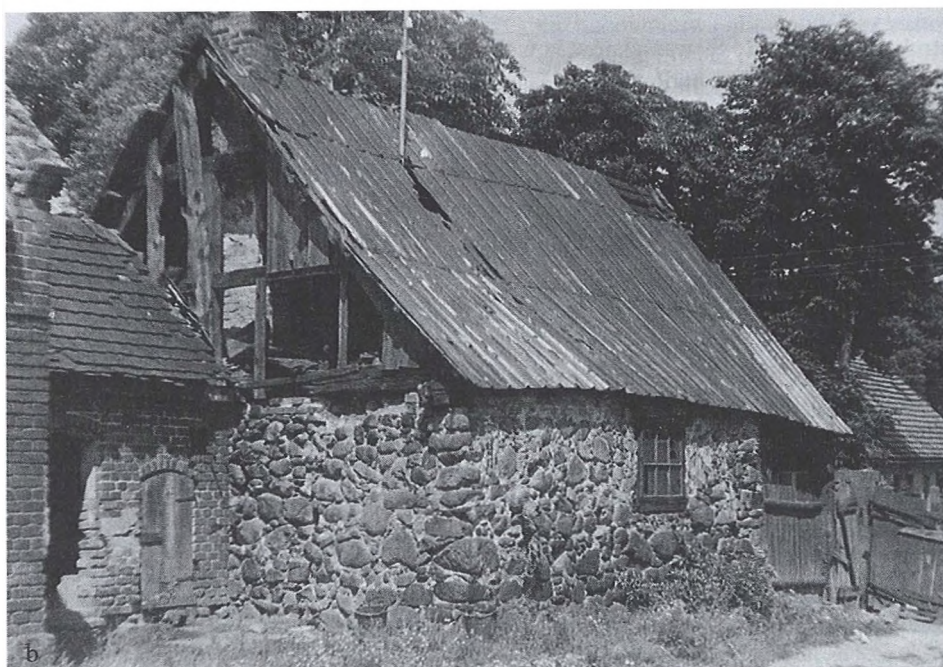
9. Kuźnia podcieniowa (XVIII w.). Kosieczyn, pow. Międzyrzecz (stan z końca lat 50-tych XX w.): a) ściana szczytowa wypełniona „strychulcami”; b) ściany bryły budynku wzniesione z kamienia polnego, fot. Z. Jasiewicz
