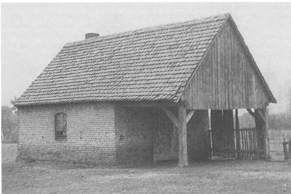
3. Kuźnia murowana z cegły z wystawką wspartą na dwóch słupach. Sokołowo pow. Czarnków (stan z końca lat 50-tych XX w.), fot. Z. Jasiewicz
