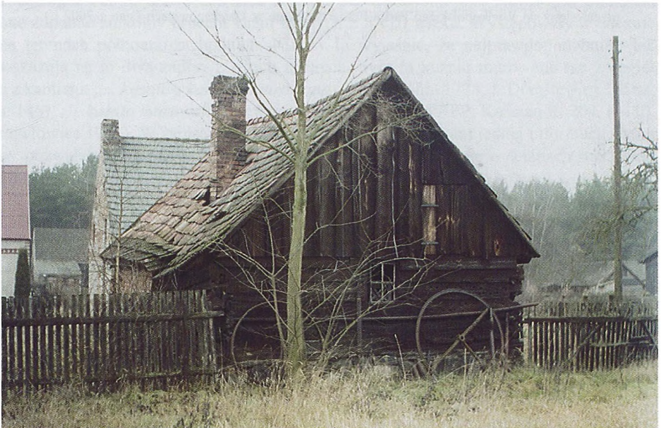
10. Osiemnastowieczna kuźnia z zachowanym fragmentem ściany konstrukcji węglowej. Kamiennik, pow. Czarnków (stan z 2001 r.), fot. A. Pelczyk
