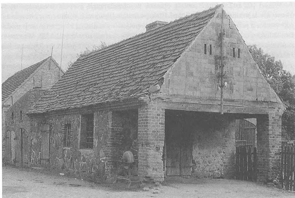
17. Kuźnia murowana z wystawą wspartą na słupach ceglanych. Stary Dwór, pow. Międzyrzecz (stan z lat 50-tych XX w.), fot. Z. Jasiewicz
