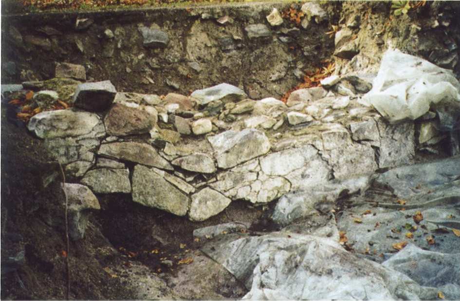
Fot. 1. Mur północny zamykający przestrzeń międzywieżową — widok od wnętrza Fot. A. Kaszubkiewicz
