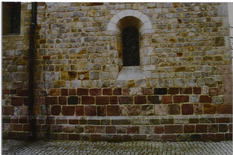
Ryc. 2. Ciosy z glazów eratycznych oraz powyżej ciosy piaskowcowe. Rekonstrukcja otworu okiennego z piaskowca magurskiego z Osielca. (ściana południowa kolegiaty)
