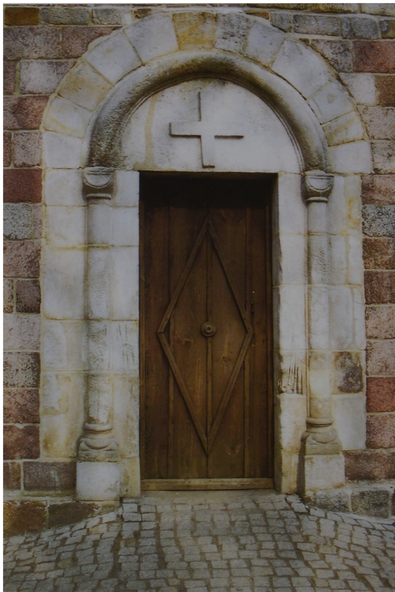
Ryc. 11. Piaskowcowy portal południowy transeptu z widocznymi śladami ostrzei toporów rycerzy średniowiecznych na wysokości ok. 1 m n.p.t.
