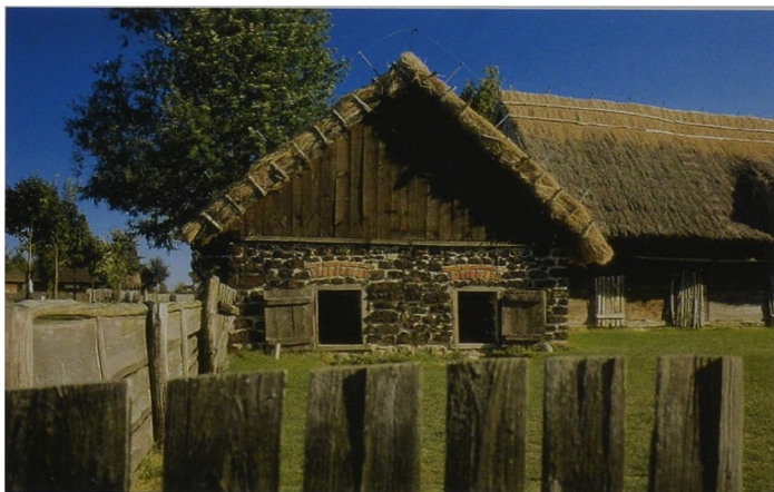
Ryc. 10 Piwnica z Końskiej Wsi wzniesiona z rudy darniowej spojonej zaprawą wapienno-piaskową. Wielkopolski Park Etnograficzny w Dziekanowicach (fot. Zb. Wielgosz 2003)
