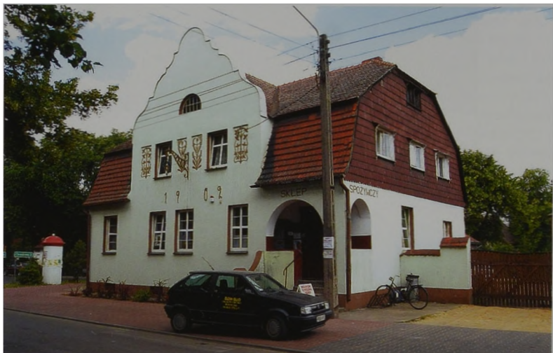
Ryc. 14 a, b, c, d Przykłady budownictwa murowanego we wsi Gołęczewo (pow. poznański), w latach 1901-1918 wzorcowej wsi niemieckiej: a) dawna karczma; b) zagroda szeregową: budynek mieszkalny, chlew, stodoła; c) budynek mieszkalny, d) budynek mieszkalny, (fot. A. Pelczyk 2008)
