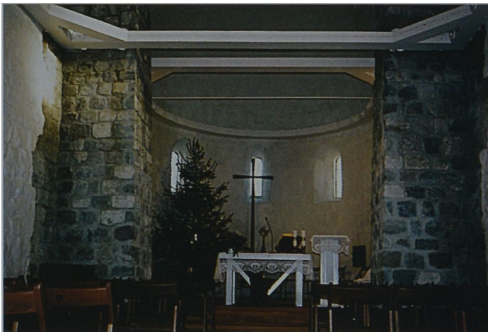
Fot. 3 Giecz- prezbiterium romańskiego kościoła p.w. Wniebowzięcia NMP i św. Mikołaja w styczniu 2008 r. (fot. T. Krysztofiak) Photo 3 Giecz- Presbyterium der romanischen Kirche der Mariä Himmelfahrt und St. Nikolaus im Januar 2008 (Photo T. Krysztofiak)
