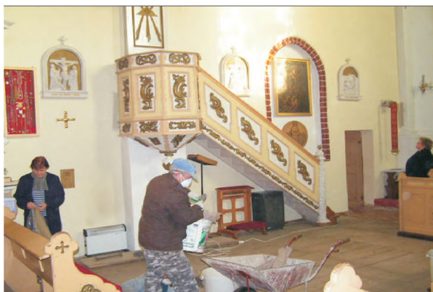
Fot. 1. Niepruszewo, remont w kościele p.w. św. Wawrzyńca (fot. J. Wrzesiński) Niepruszewo, renovation in St Lawrence's church (photograph by J. Wrzesiński)
