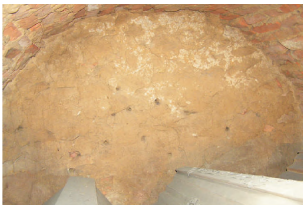
Fot. 12. Niepruszewo, ściana tylna krypty (fot. J. Wrzesiński) Niepruszewo, the back wall of the crypt (photograph by J. Wrzesiński)
