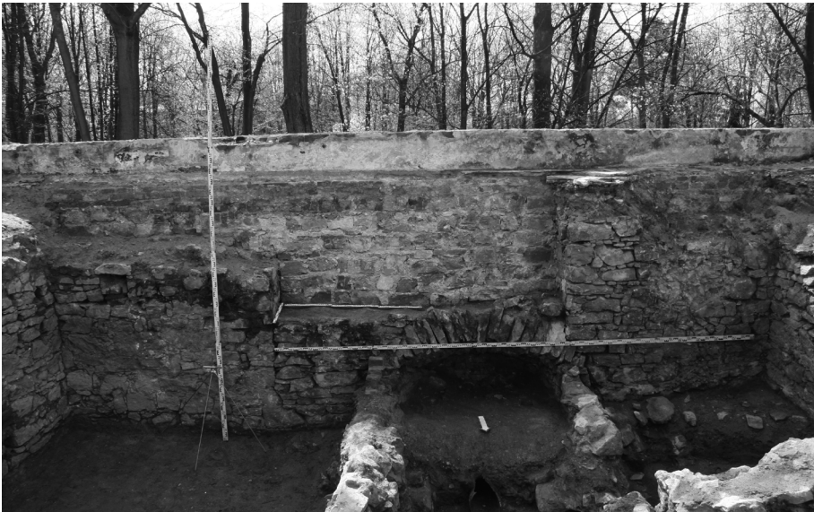
5. Wykop I, profil S
