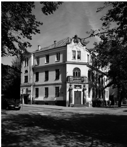
2. Łaźnia – widok od południowego wschodu; fot. K. Myśliński 2009 r.
