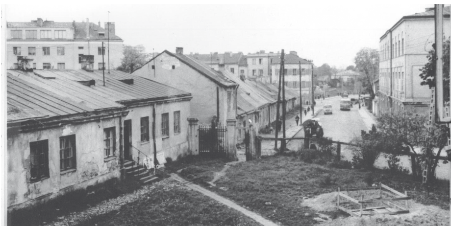
Zabudowa przy krańcu ul. Wesolej, przy Rogatce Krakowskiej (przed rozbiórką)
