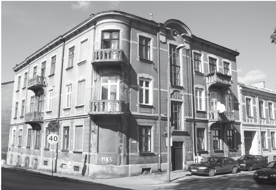
Kamienice Grimma, ul. Słowackiego 30 i 32
