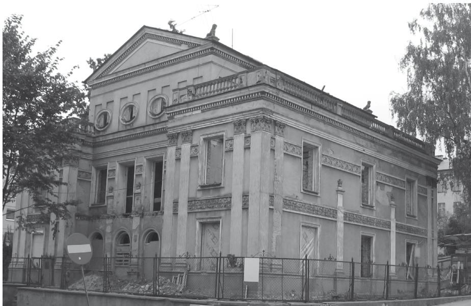
Dawna willa Hüetów, ul. Słowackiego 25, w trakcie remontu w 2011 r.
