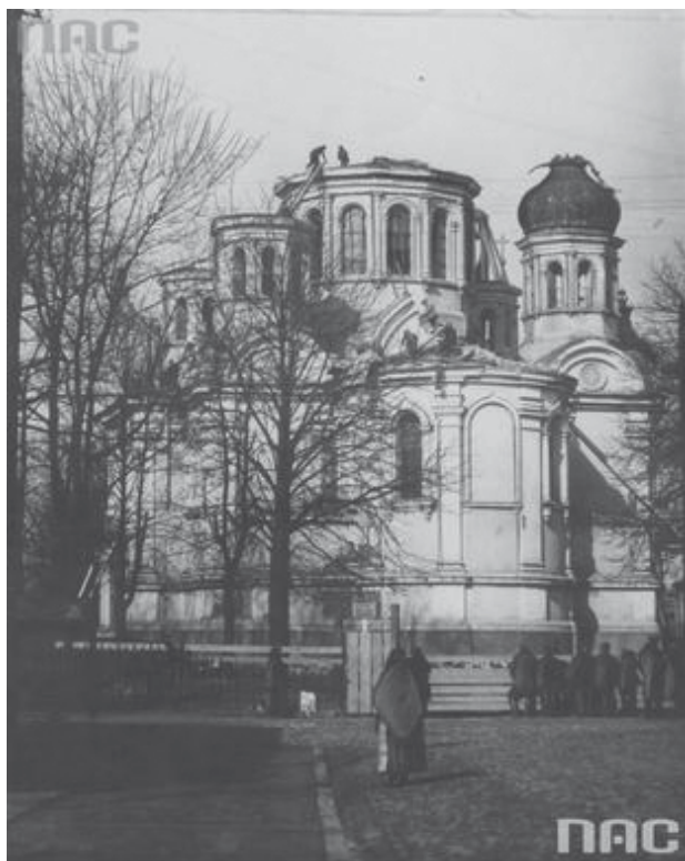
Prace rozbiórkowe przy dawnym soborze Wniebowstąpienia w 1933 r.
