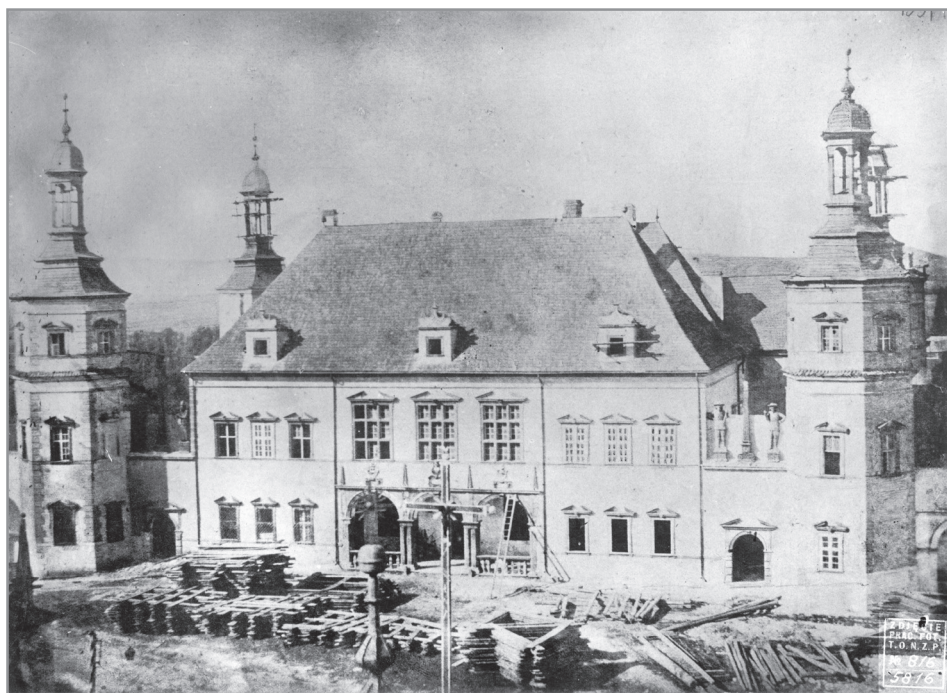
Prace remontowe przy przebudowie Pałacu Biskupów Krakowskich na siedzibę Gubernatora i Rządu Gubernialnego Kieleckiego w 1866 r., odbitka reprodukcyjna; Archiwum WUOZ w Kielcach
