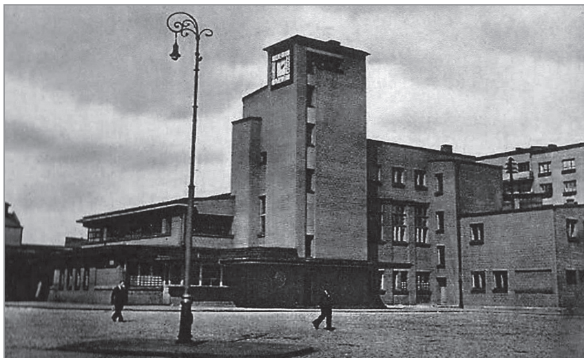
Dworzec kolejowy Będzin Miasto, proj. E.A. Norwerth; fot. z archiwum autorki
