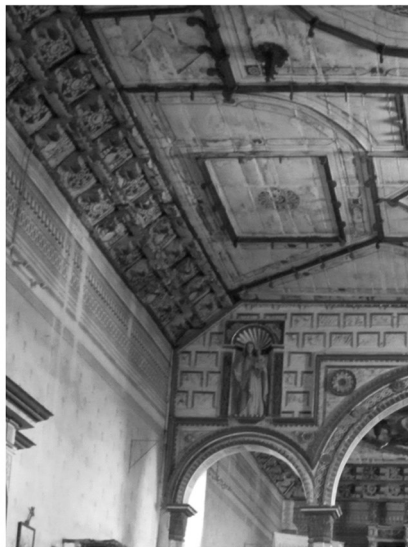
[Fig. 4. Sistema de vigas sobre zapatas.]
