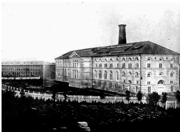
Il. 4. Młyn parowy na Solcu w Warszawie, arch. Adolf Schuch, 1826–1827, fotografia z ok. 1880 roku, w zbiorach Muzeum Narodowego w Warszawie, wg Rottermund (1990: il. 107)
