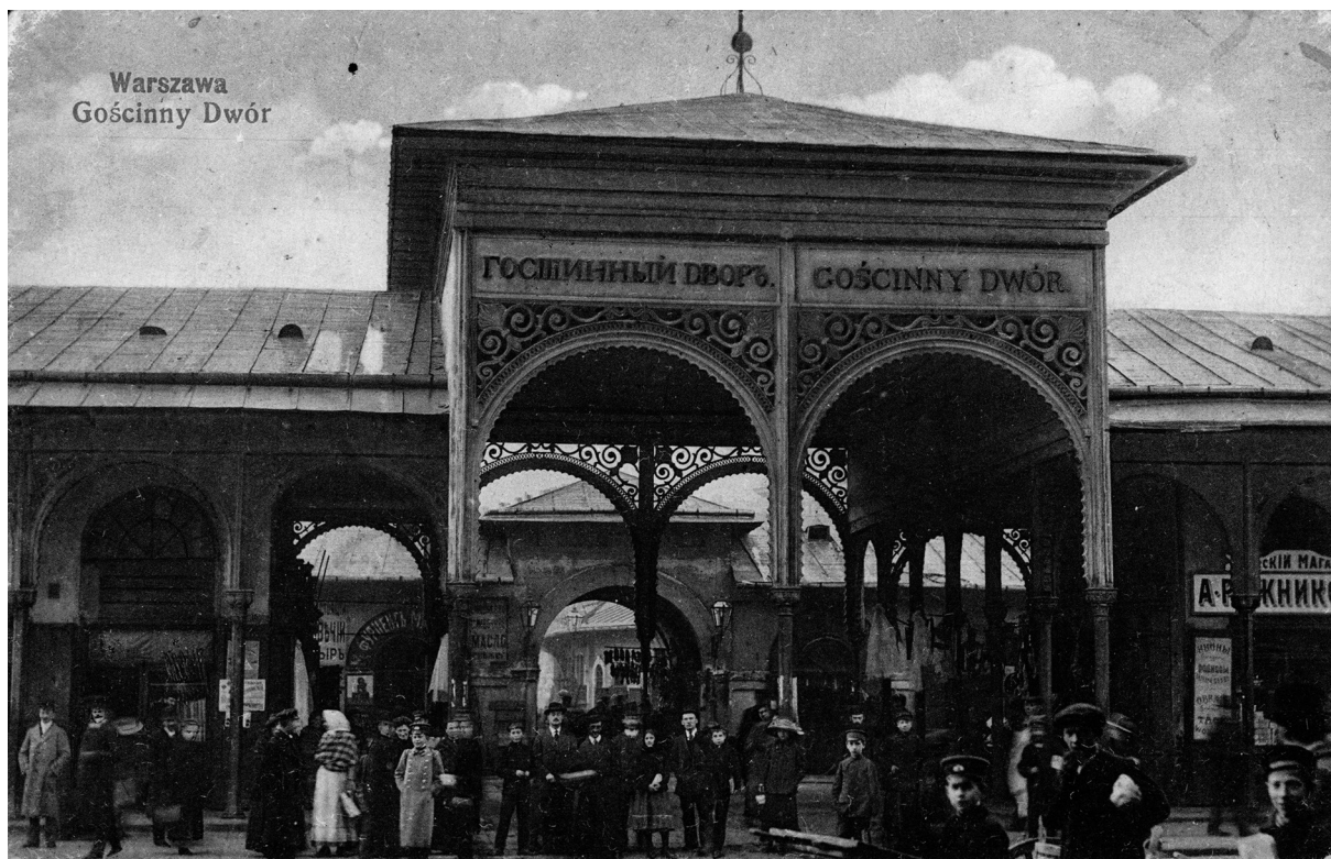
Il. 10. Gościnny Dwór przy pl. Za Żelazną Bramą w Warszawie, arch. Jan Jakub Gay i Alfons Kropiwnicki, 1841, pocztówka z ok. 1910, w zbiorach Biblioteki Narodowej w Warszawie
