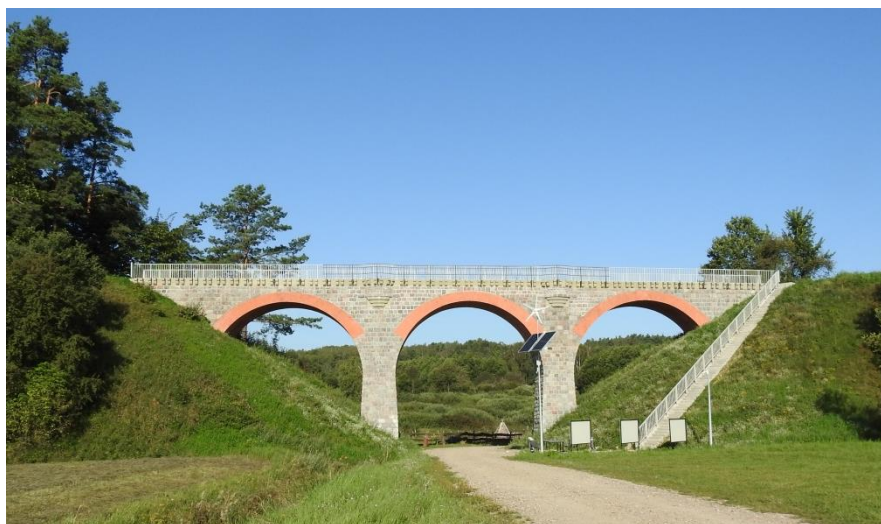
Ryc. 7. Most kolejowy w Glaznotach po remoncie konserwatorskim
