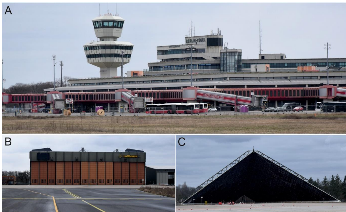
Ryc. 6. Dawny port lotniczy Tegel. A – budynek terminalu lotniczego i wieża kontroli lotów od strony płyty lotniska, B – dawny hangar Lufthansy, C – zadaszona konstrukcja służąca do sprawdzania poprawności pracy silników samolotów
