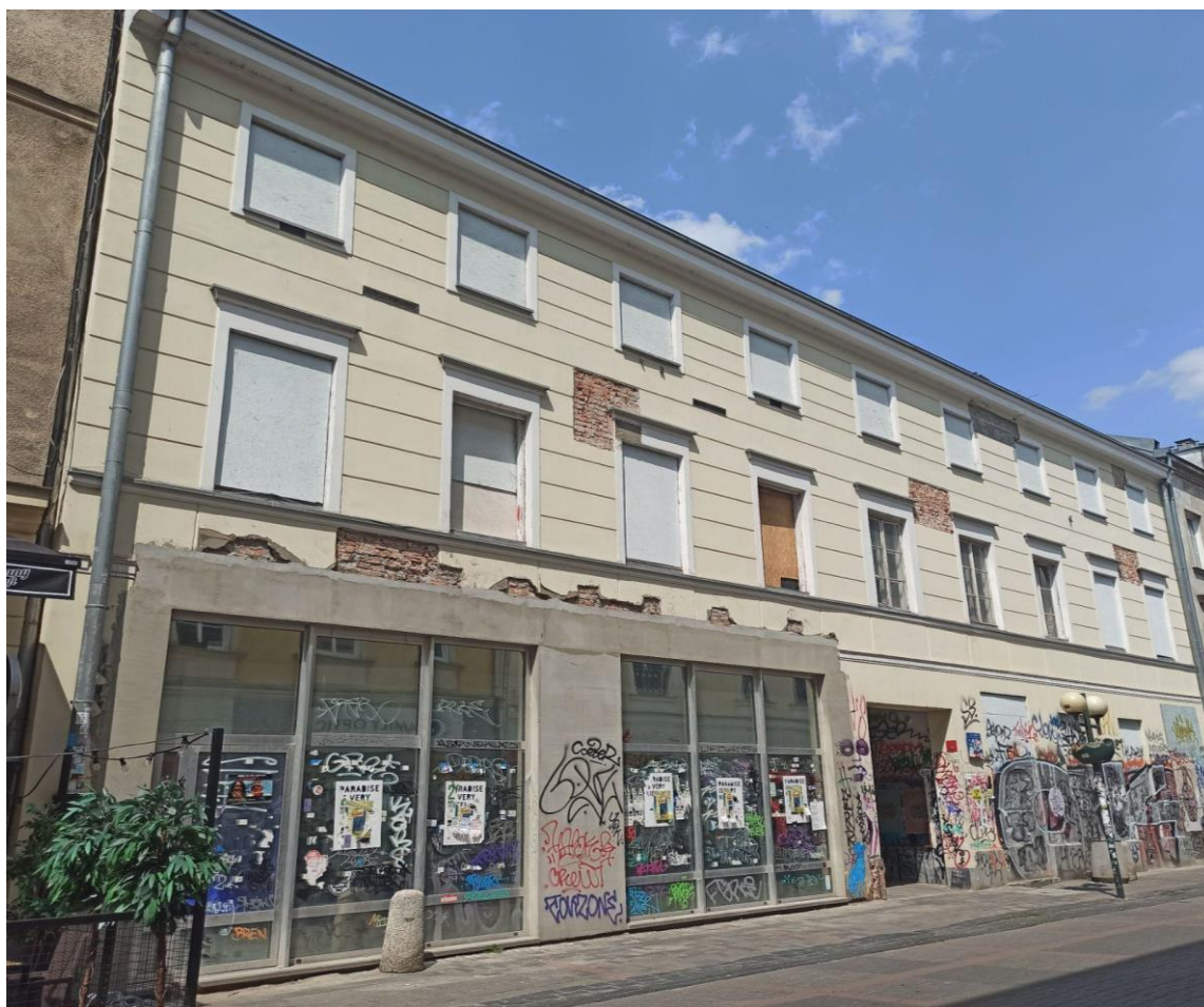
Ryc. 15. Kamienica Jaroszyńskich przy ulicy Chmielnej 18 Źródło: Fotografia własna, Warszawa 2023 rok
