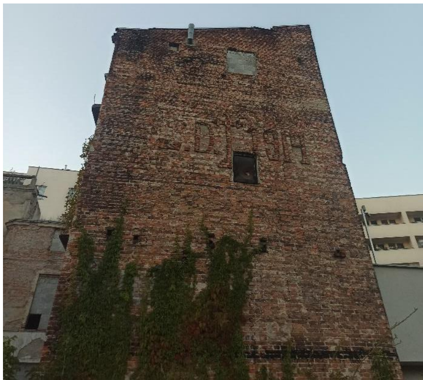
Ryc. 8. Boczna fasada, tylnej oficyny kamienicy Leona Doleya, przy ulicy Chodakowskiej 22 Źródło: Fotografia własna, Warszawa 2023 rok
