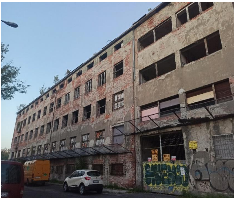
Ryc. 9. Fabryka odbiorników radiowych Telefunken przy ulicy Owsianej 14 i Owsianej 14 A Źródło: Fotografia własna, Warszawa 2023 rok
