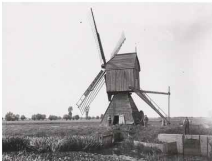
Fot. 6. Wiatrak odwadniający w Mirowie na Żuławach, zdjęcie archiwalne z wystawy towarzyszącej konferencji "Kraina Wiatraków Powraca", Nowy Dwór Gdański 2007 r. źródło: www.wrotapomorza.pl
