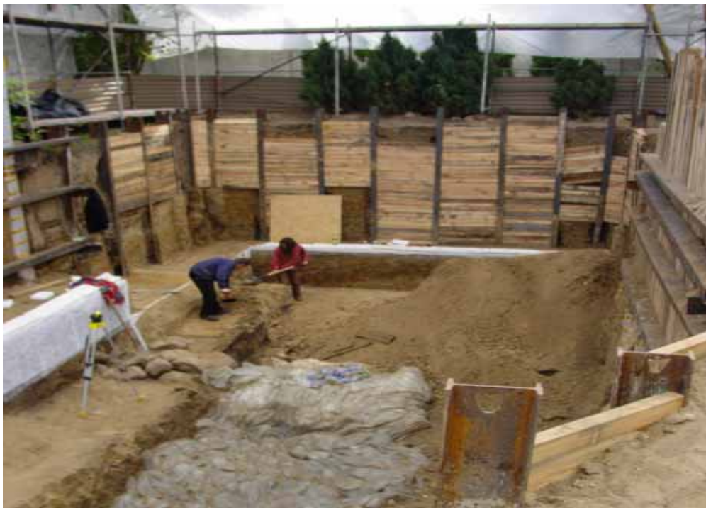
Fot.2. Teren badań na północy Ostrowa Tumskiego – mury pałacu biskupów (prace wykopaliskowe październik 2009). Źródło: zdjęcie własne autorki
