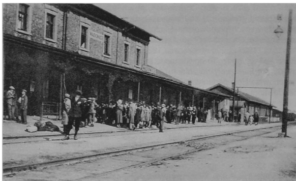
WADOWICE i Wnizac kolejowy.
