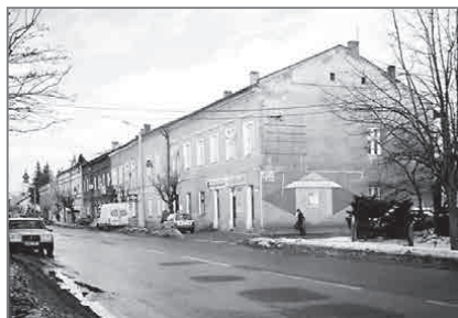
fot. 3. Wadowice. Starszy budynek małych koszar od strony Skawy. Na pierwszym planie segment 5. (6-okienny), za nim 4. (2-okienny, obecnie pozbawiony przyczółka) i 3. (6-okienny) – wszystkie jasne. W głębi ciemne segmenty 2. i 1., a za nimi jasny budynek, młodszy
