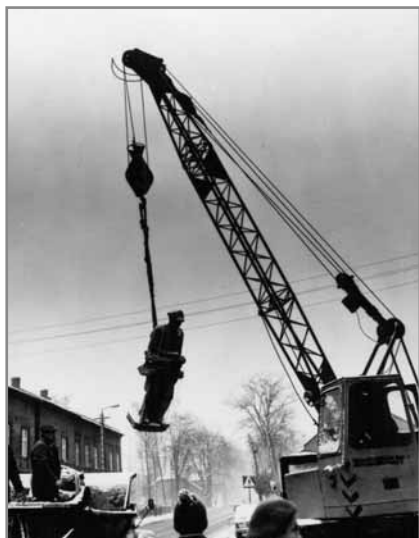
Montaż pomnika przed koszarami (listopad 1981 r.) (zbiory wadowickiej Solidarności)
