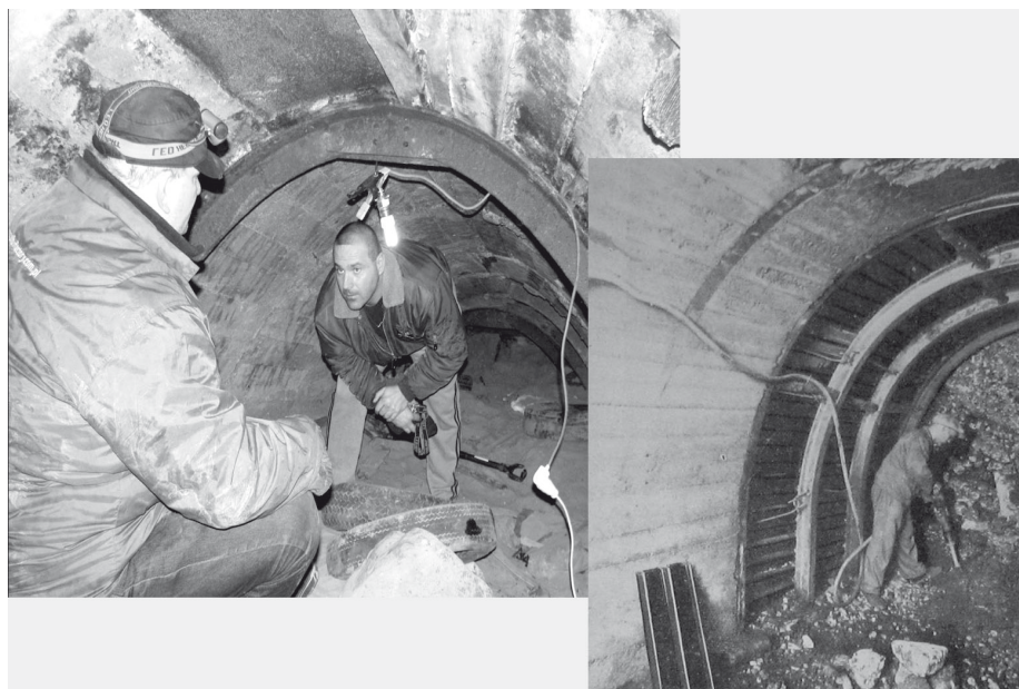
Schron typu tunelowego
